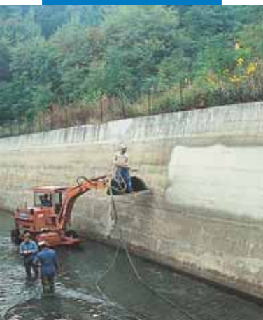
Idrosilex Pronto aplicat prin pulverizare intr-un canal hidro-electric
