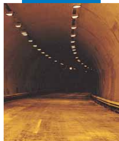
Idrosilex Pronto alb aplicat prin pulverizare intr-un tunel de autostrada
