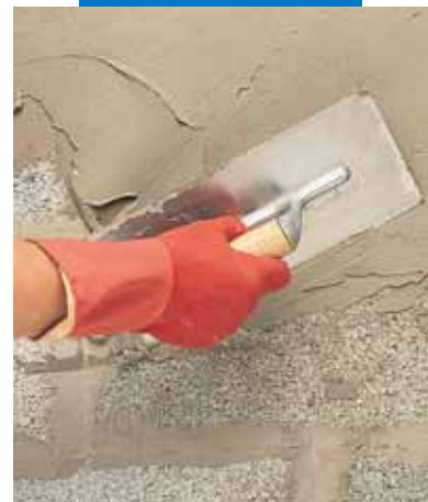
Idrosilex Pronto aplicat cu fierul de glet
