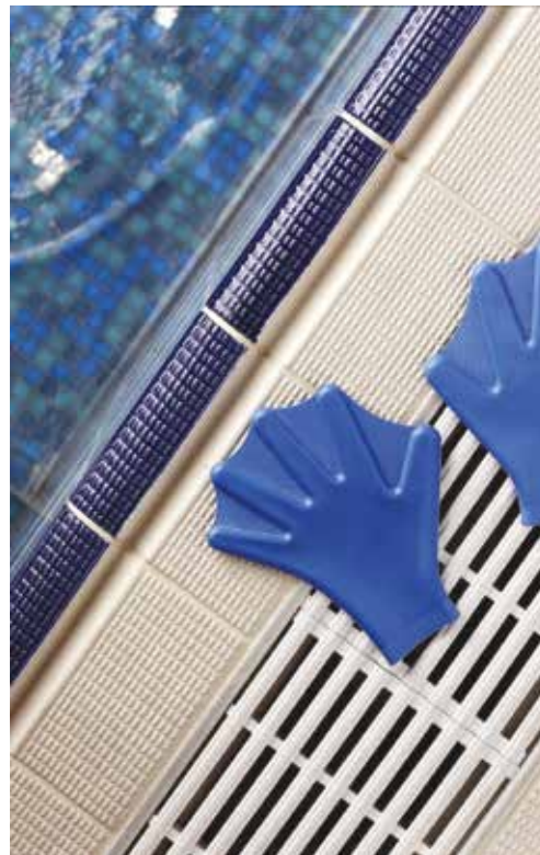
Exemplu de piscina la care placajul a fost chituit cu Ultracolor Plus
