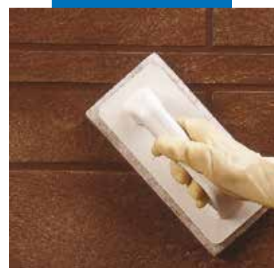
Curatarea rosturilor cu ajutorul buretelui Scotch-Brite® (cand produsul a initiat priza)
