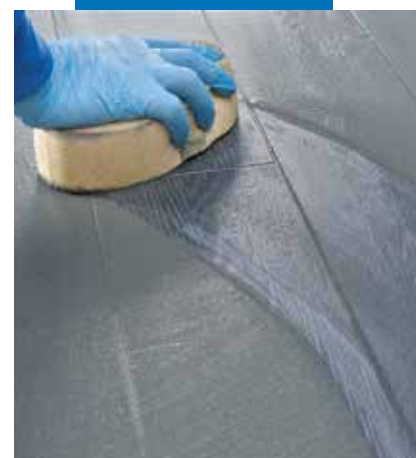
Curatarea si finisarea rosturilor cu buretele de celuloza
