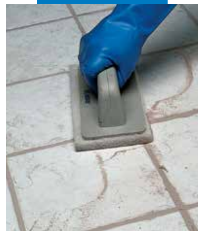
Finisarea cu un pad abraziv tip Scotch-Brite®
